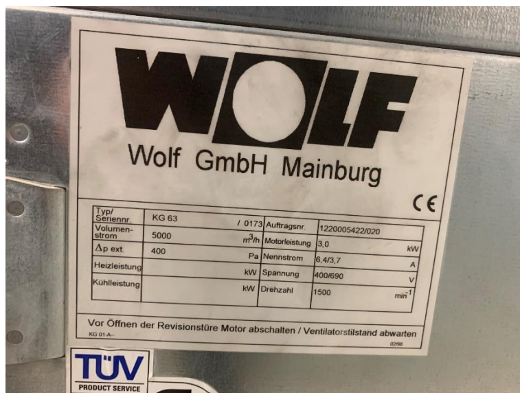
Abbildung 11 Typenschild Abluft Umkleide (© Foto: Dr. Ralf Müller)
