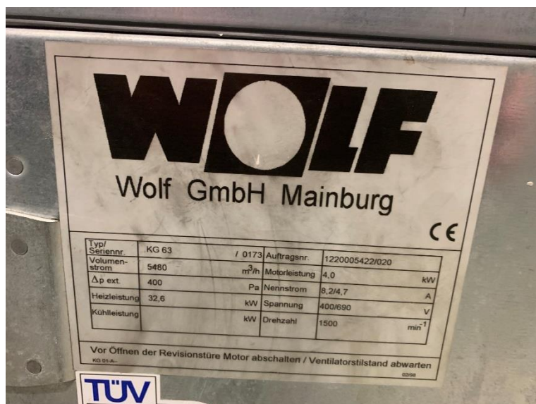
Abbildung 10 Typenschild Zuluft Umkleide (© Foto: Dr. Ralf Müller)
