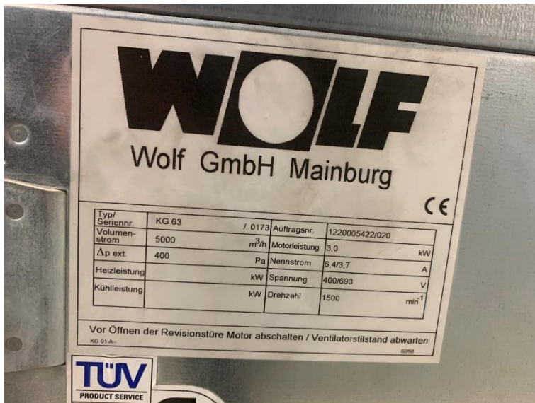
Abbildung 11 Typenschild Abluft Umkleide (© Foto: Dr. Ralf Müller)
