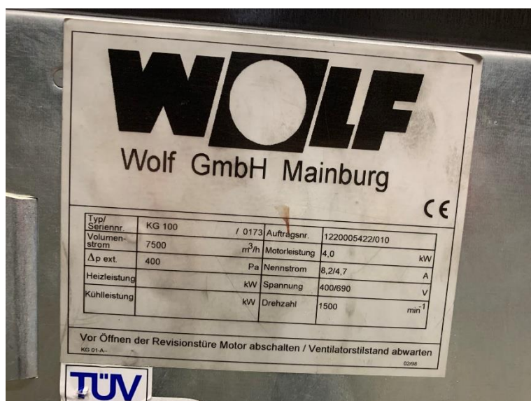
Abbildung 2 Typenschild Abluft Halle (© Foto: Dr. Ralf Müller)
